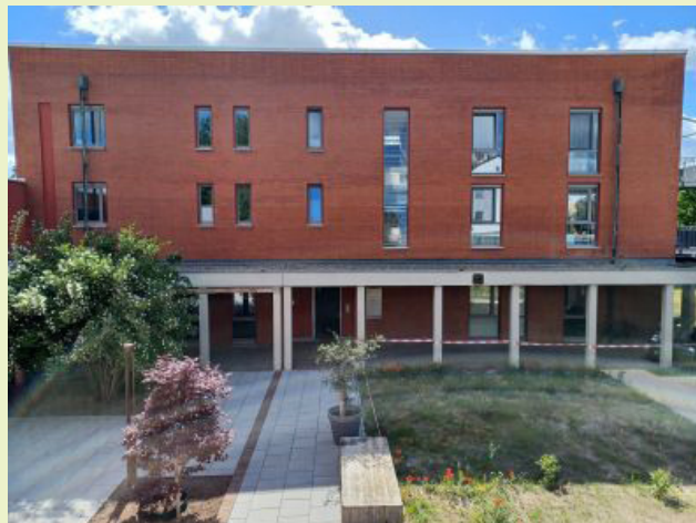
Foto: Diakoniezentrum Groß-Gerau in den ehemaligen Gebäuden der Versöhnungskirchengemeinde
